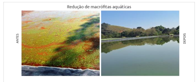
Imagem 01 - Aspecto visual antes e após 30 dias da aplicação do protocolo de biorremediação - ETE Sanitária/Lagoa facultativa.
